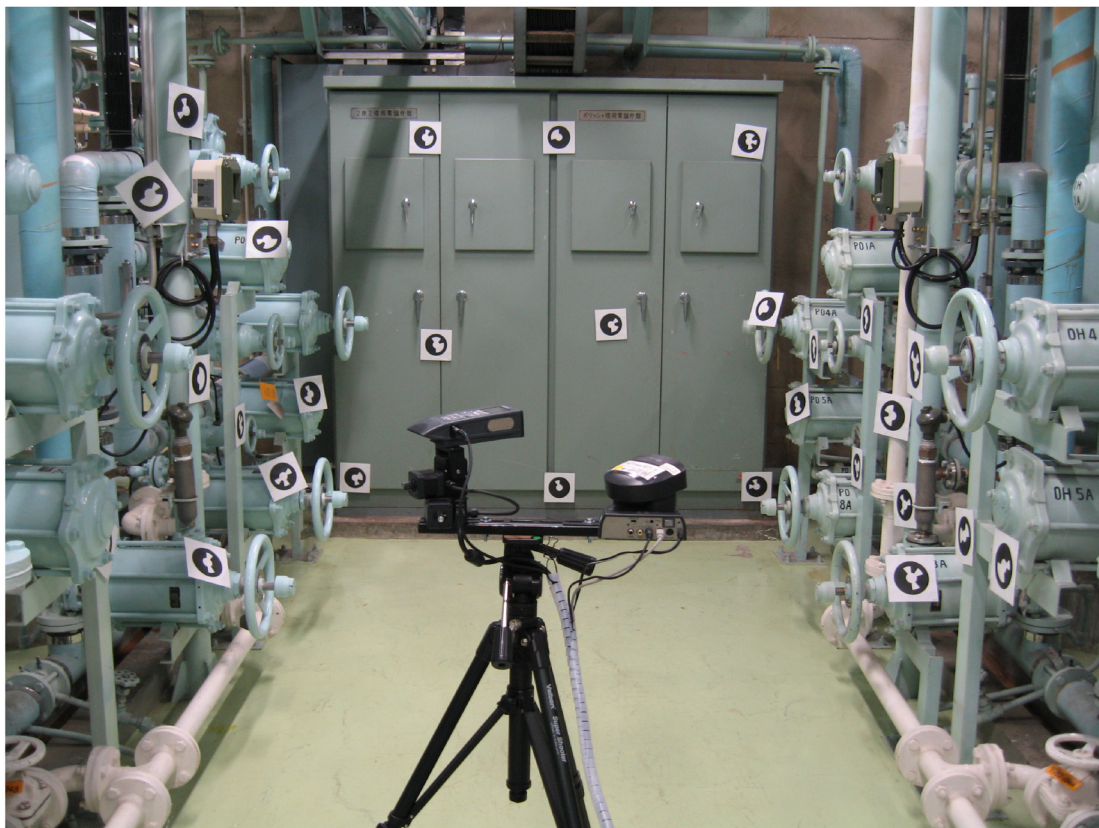
図 6.3: 純水装置室におけるマーカの貼付例
